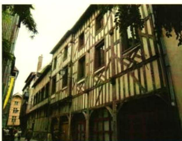
Vieille ruelle de Troyes et maison en réhabilitation
