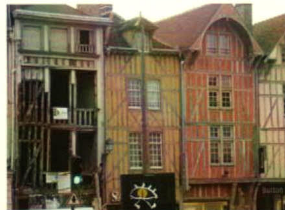
Vieille ruelle de Troyes et maison en réhabilitation
