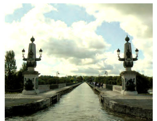
Le «Pont-Canal de Briare» au-dessus de la Loire : que c'est beau !
